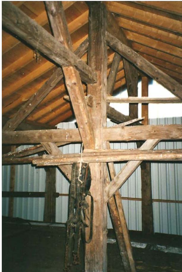
Réfection du toit et de la charpente. Les chevrons ont tous été remplacés. La façade à vent, en plastique transparent, n'est pas très heureuse.
